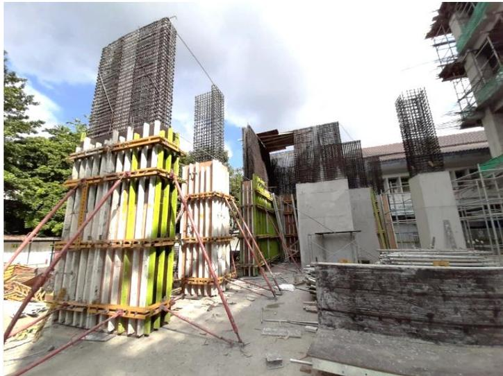
**Gambar L-8.1 Pekerjaan Kolom dan Sheer Wall**
