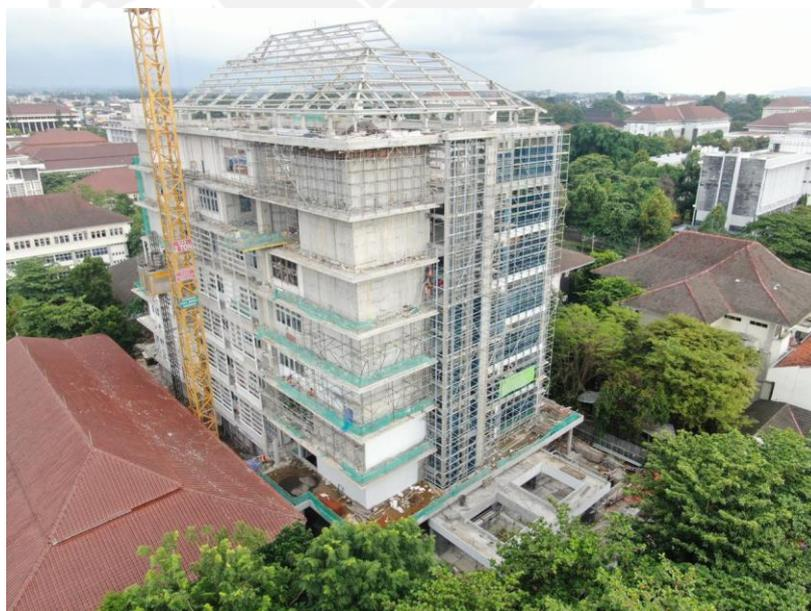
**Gambar L-8.4 Pekerjaan Rangka Atap Baja dan *Finishing***
