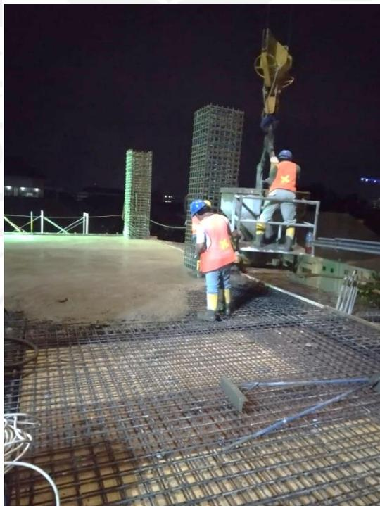
**Gambar L-8.2 Pengecoran Plat Lantai**
