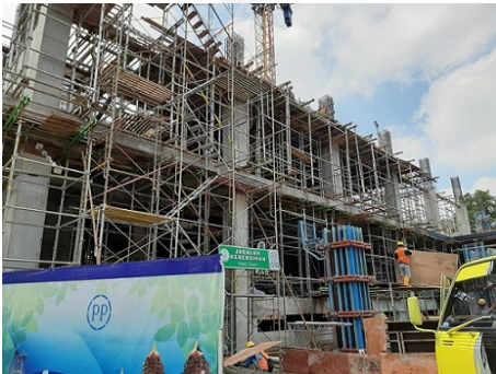
Gambar L-7.6 Bekisting Balok Pelat
