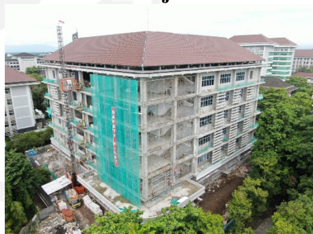
Gambar L-7.10 Tahap Finishing Pekerjaan Struktur
