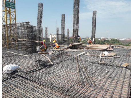
Gambar L-7.8 Pekerjaan Balok Pelat Lantai
