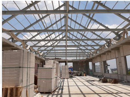
Gambar L-7.9 Pekerjaan Atap Baja
