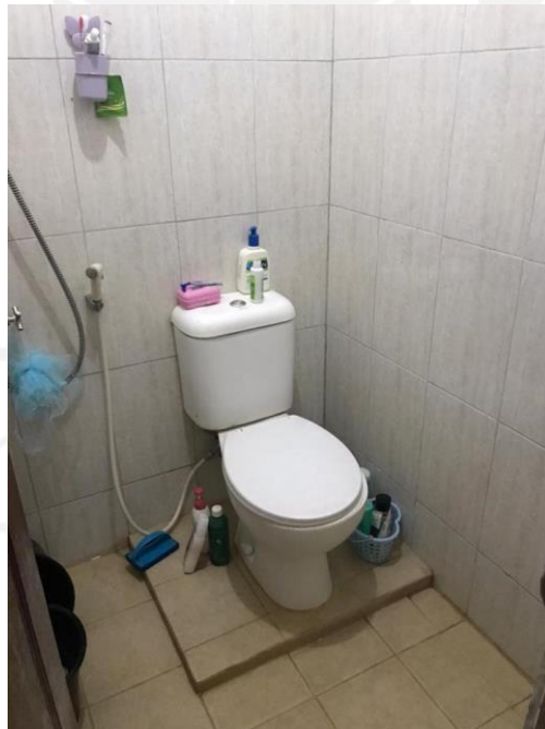
Gambar 7 Kondisi kamar mandi kos yang menggunakan kloset leher angsa
