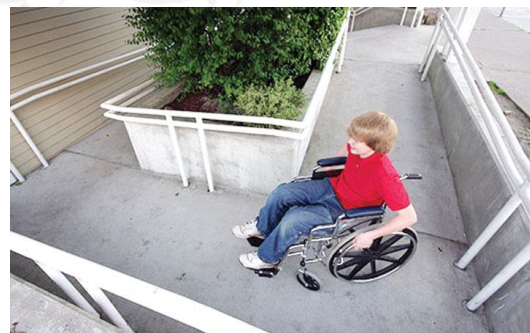
Gambar 1.10 Ramp difabel di lengkapi dengan pegangan pengaman Sumber : Google
