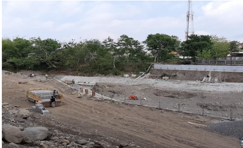
Gambar 5.1 Kondisi Proyek Pembangunan Embung UII (Sumber:Dokumentasi Pribadi)
