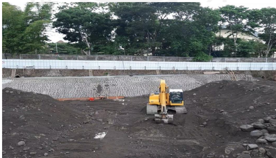
Gambar 5.2 Kondisi Pelaksanaan Proyek pembangunan Embung UII (Sumber: Dokumentasi Pribadi)
