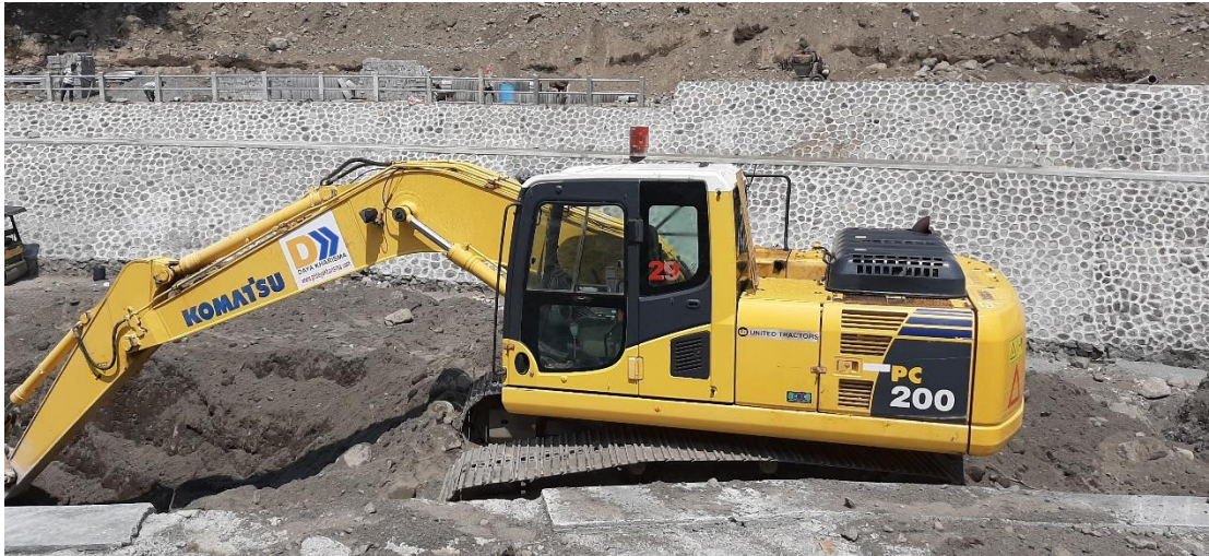
Gambar 4.2 Alat Gali Excavator Komatsu PC-200 (Dokumentasi Pribadi)
