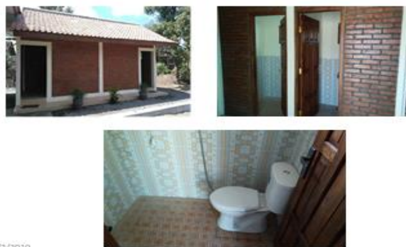
Gambar 11. Toilet Baru SDN Ngebelgede II
