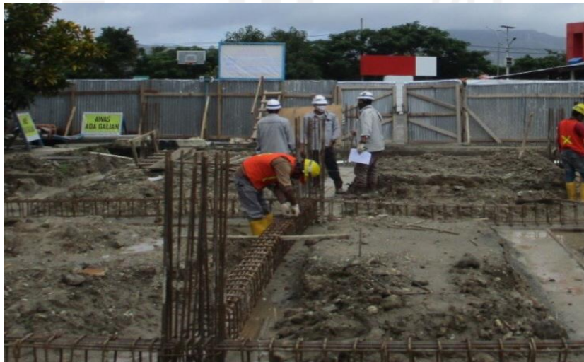
Gambar L-3.4 Pekerjaan pembesian gedung MTC Room pada proyek pembangunan Pada proyek pembangunan Terminal LPG Pressurized Wayame Ambon
