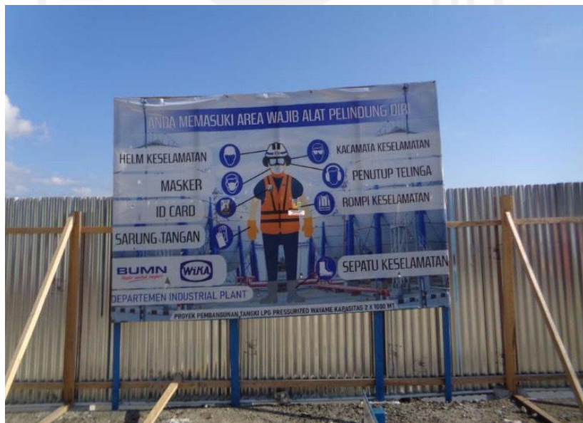
Gambar L-3.6 Rambu K3 arahan pemakaian alat pelindung diri pada pekerja pada proyek pembangunan Pada proyek pembangunan Terminal LPG Pressurized Wayame Ambon.
