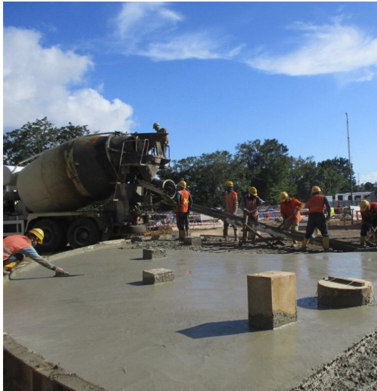
Gambar L-3.8 Pekerja mengutamakan Alat pelindung diri saat bekerja Pada proyek pembangunan Terminal LPG Pressurized Wayame Ambon.
