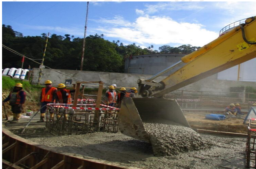
Gambar L-3.2 Pengecoran Pondasi Tangki Pada proyek pembangunan Terminal LPG Pressurized Wayame Ambon
