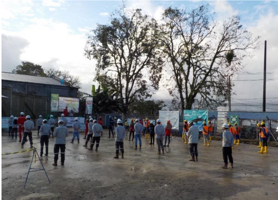
Gambar L-3.5 Safety Briefing kepada pekerja pada proyek pembangunan Pada proyek pembangunan Terminal LPG Pressurized Wayame Ambon.
