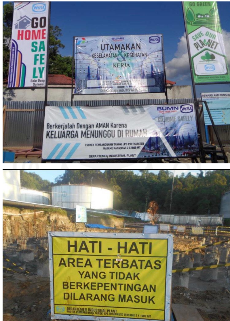
Gambar L-3.7 Rambu K3 proyek pembangunan Pada proyek pembangunan Terminal LPG Pressurized Wayame Ambon.
