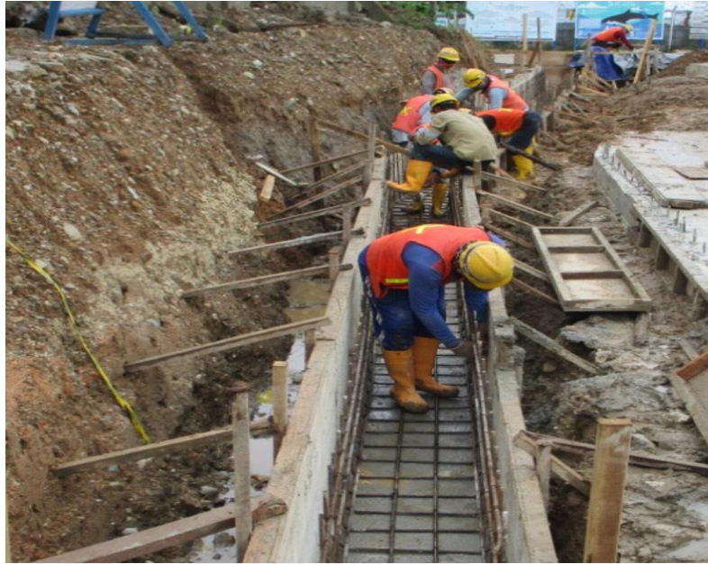
Gambar L-3.3 Pekerjaan bekisting dinding penahan tanah proyek pembangunan Pada proyek pembangunan Terminal LPG Pressurized Wayame Ambon
