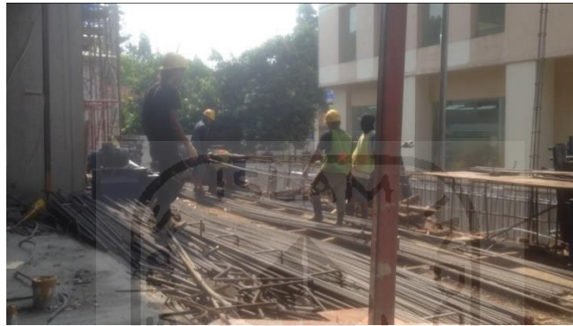
Gambar 5.5 Lokasi Pembesian Kolom
