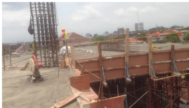
Gambar 5.6 Kondisi Cuaca Lapangan
