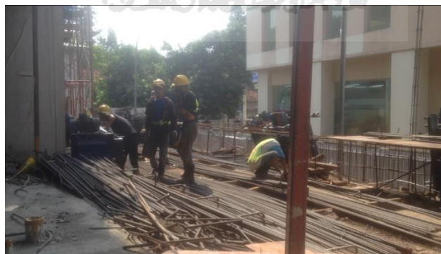
Gambar 5.4 Pembesian Kolom Oleh Pekerja
