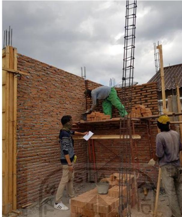
**Gambar L-1.5** Pekerjaan Dinding Bata Merah Proyek Pembangunan Kost & Hunian Eksklusif Lantai 2
