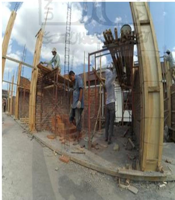
**Gambar L-1.8** Pekerjaan Dinding Bata Merah Proyek Pembangunan Kost & Hunian Eksklusif Lantai 2
