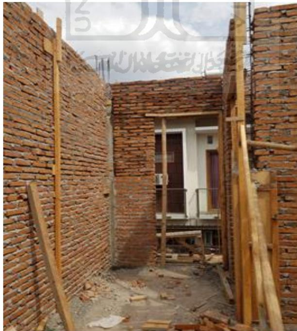
**Gambar L-1.6** Pekerjaan Dinding Bata Merah Proyek Pembangunan Kost & Hunian Eksklusif Lantai 2
