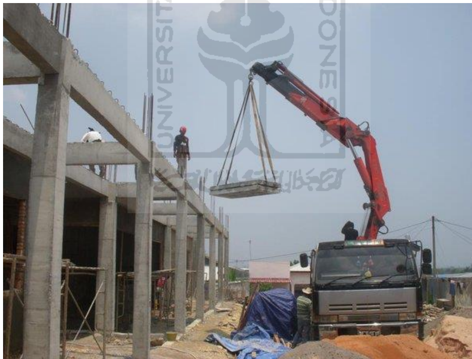
Gambar 5.5 Penggunaan Mobile Crane pada Instalasi Pelat Lantai Hollow Core Slab .
