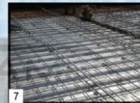
7 Pasang jaring kawat baja las Place wire mesh
