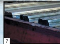
7 Pemasangan bila menggunakan endstop karet Installation if using rubber endstop
