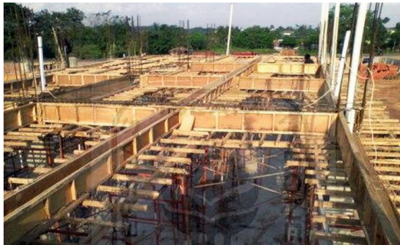
Gambar 5.2 Pemasangan Bekisting pada Pelat Lantai Metode Konvensional.
