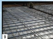
9 Pasang jaring kawat baja las Place wire mesh
