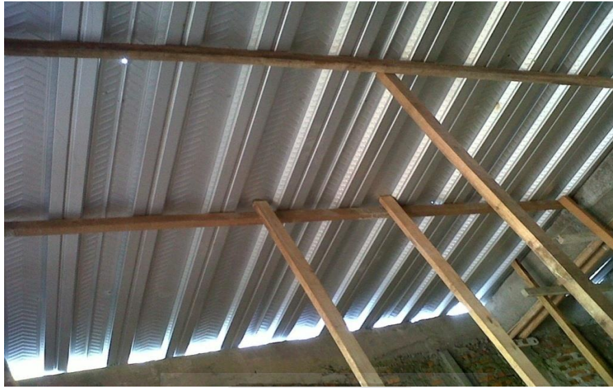
Gambar 5.4 Kayu Penyangga pada Pelat Lantai Metode Floordeck .
