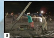
8 Penuangan beton Pour concrete
