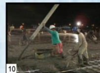
10 Penuangan beton Pour concrete
