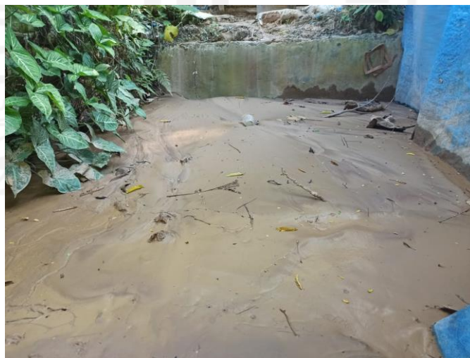
Gambar 1 Bak Penampung Tailing Sementara Sumber: Dokumentasi Pribadi
