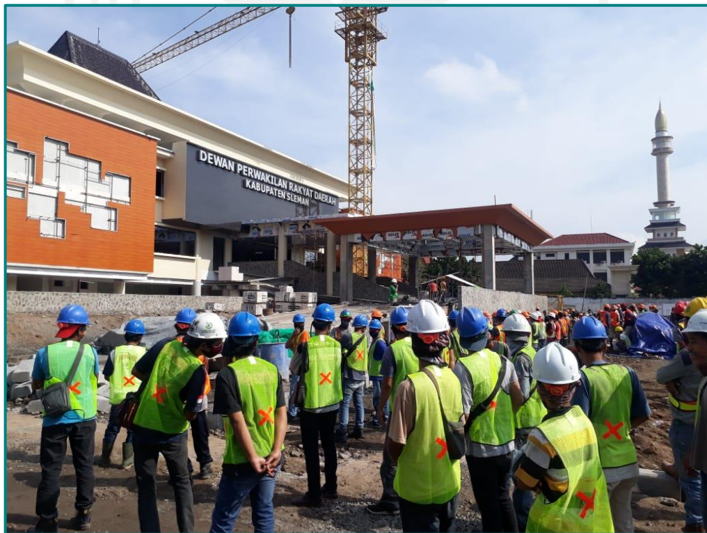
Gambar 5. 2 Proyek Pembangunan Gedung DPRD Sleman (Sumber: Dokumen Penulis)
