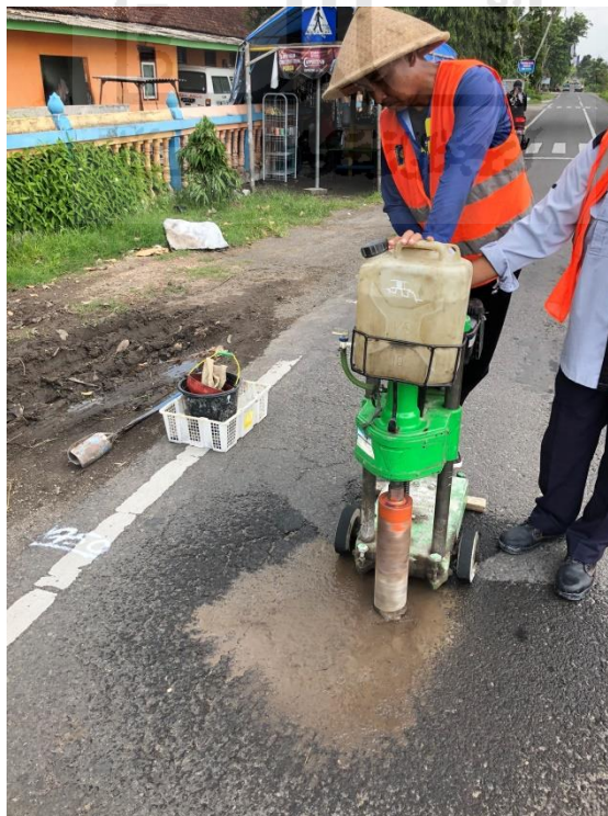
Gambar L – 6.2 Pengambilan Sampel Benda Uji Menggunakan Core Drill
