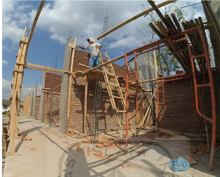
Lampiran 1.3 Pemasangan Dinding Bata L2 Segmen II – 19a
