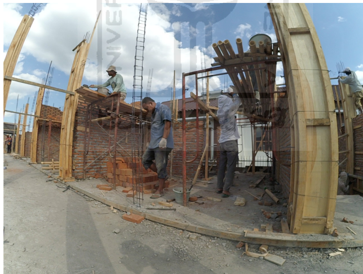
Lampiran 1.4 Pemasangan Dinding Bata L2 Segmen I – 14a, 14X
