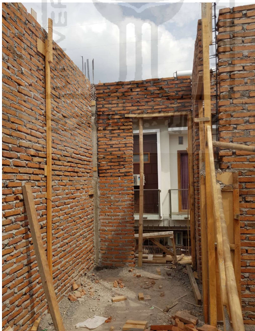
Lampiran 1.2 Pemasangan Dinding Bata L2 Segmen II - 15e, 15c
