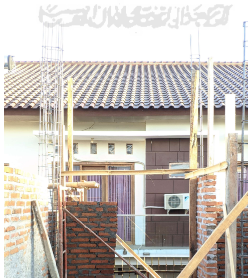
Gambar 5. 5 Kondisi Cuaca di Lapangan
