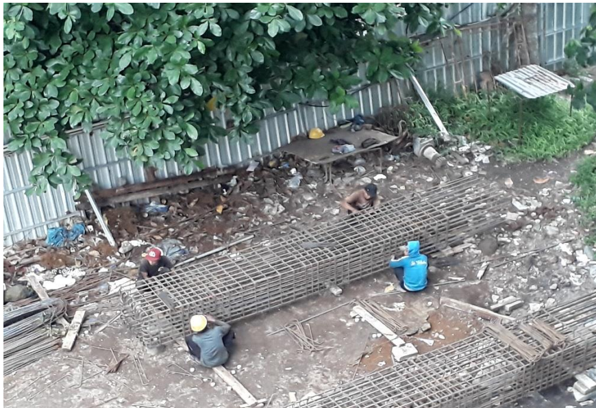
Gambar L-1. 4 Perakitan Tulangan Kolom
