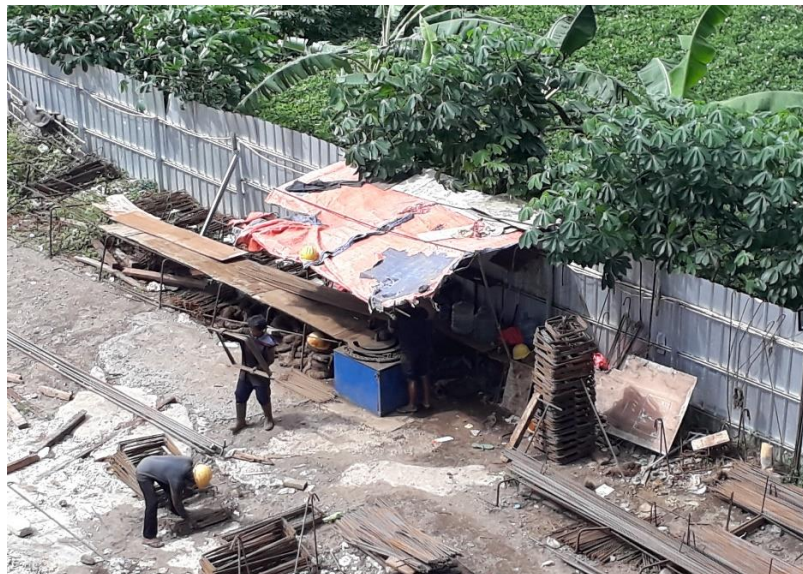
Gambar L-1. 2 Pabrikasi Tulangan Kolom
