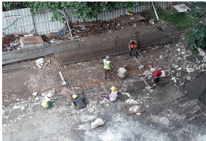
Gambar 5.3 Pembesian Kolom Oleh Pekerja
