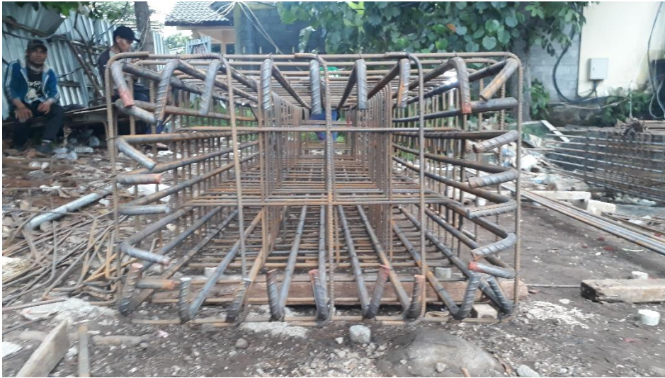
Gambar L-1. 5 Penampang Atas Tulangan Kolom
