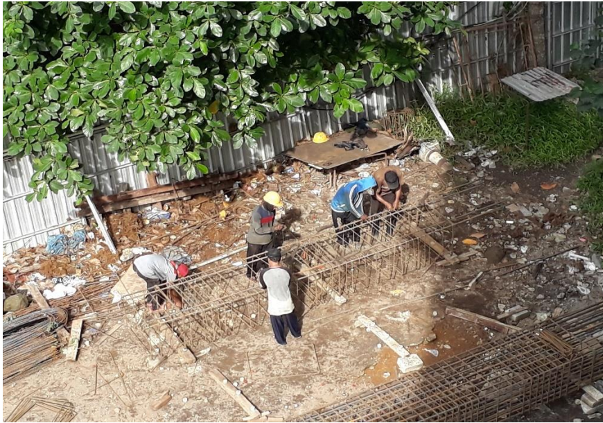
Gambar L-1. 3 Marking Tulangan Kolom
