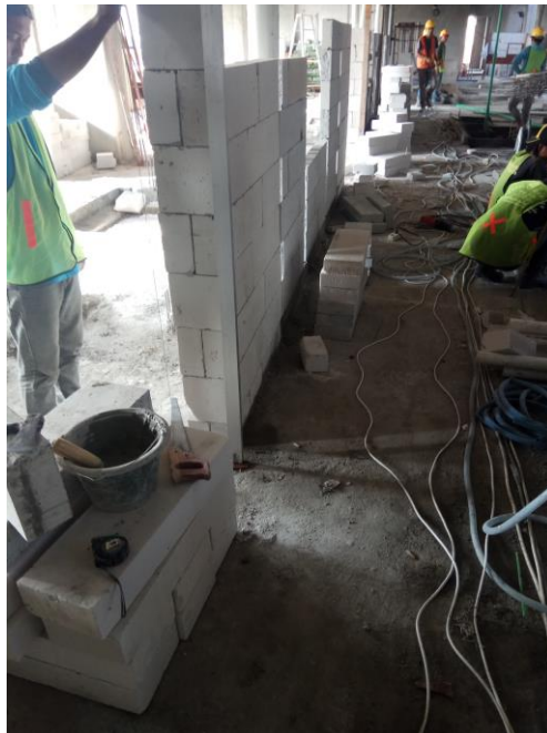
Gambar L-1.2 Situasi di Lapangan Lantai 3 (2)
