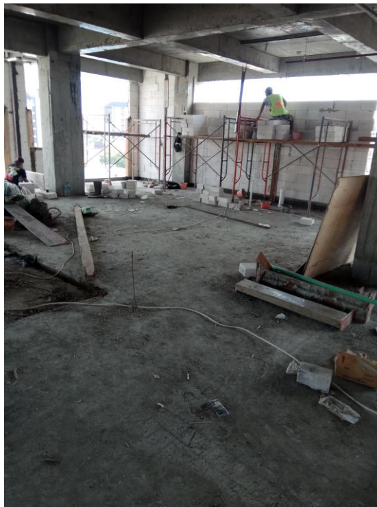
Gambar L-1.4 Situasi di Lapangan Lantai 4 (2)
