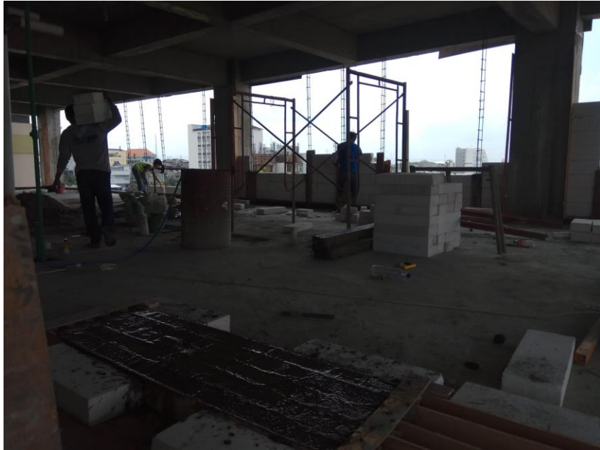
Gambar L-1.3 Situasi di lapangan Lantai 4 (1)
