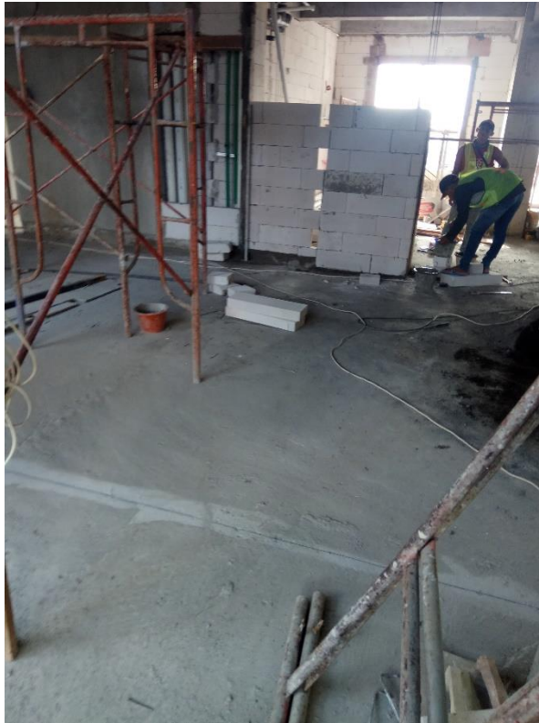
Gambar L-1.1 Situasi di Lapangan Lantai 3 (1)
