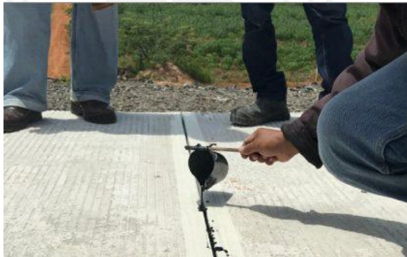
Gambar 5.7 Pekerjaan penyegelan sambungan pada perkerasan kaku
