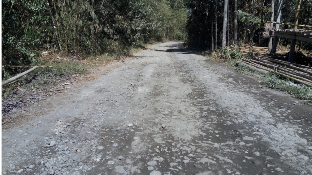
Gambar 1.1 Kondisi jalur evakuasi ruas jalan Balong-Plosokerep
