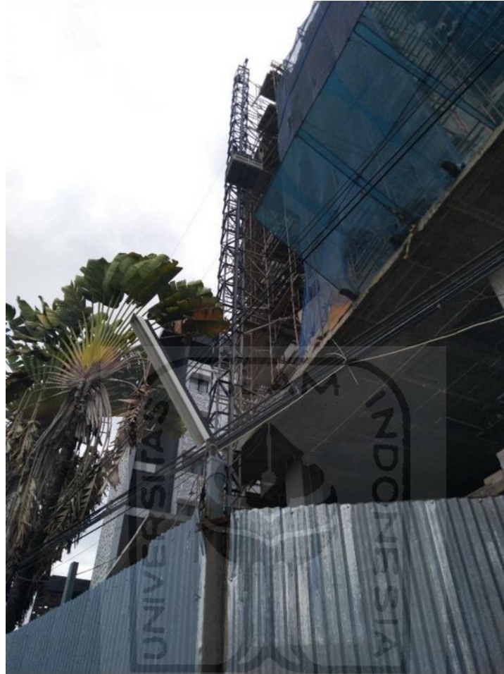
Gambar L-1. 3 Bucket Material Hoist Memuat Material Keramik 60x60
