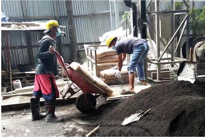
Gambar L-1. 4 Bucket Material Hoist Memuat Material Keramik 60x60
