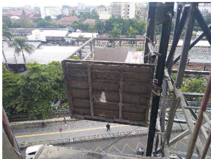
Gambar L-1. 3 Bucket Material Hoist Memuat Material Keramik 60x60
