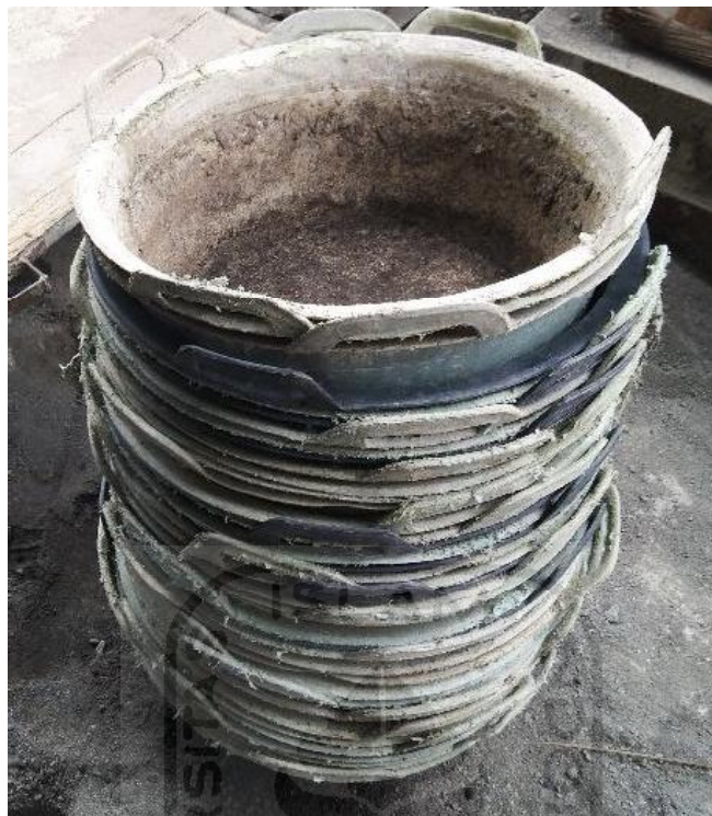
Gambar L-1. 10 Ember Penampung Pasir Saat Transfer Material
