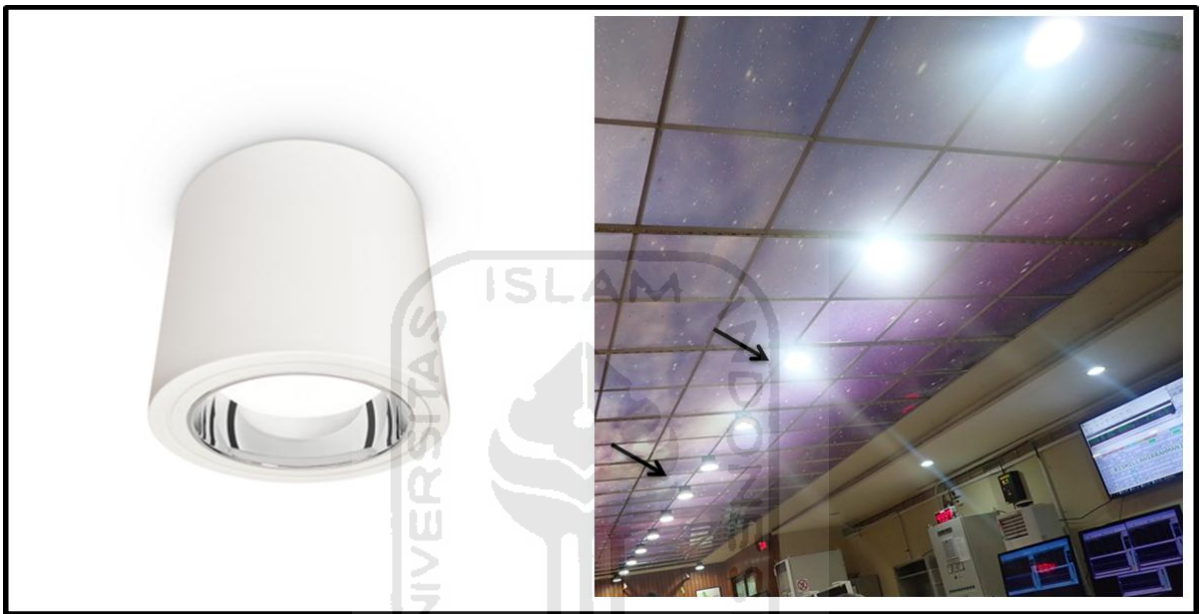
Gambar 4. 16 Perbaikan Yang Dilakukan Dengan Pemasangan Downlight LED Pada Langit-langit Control Room
