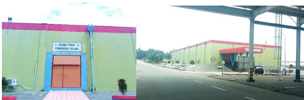
Gambar 2.1 Gedung Ruang Kendali Kilang
