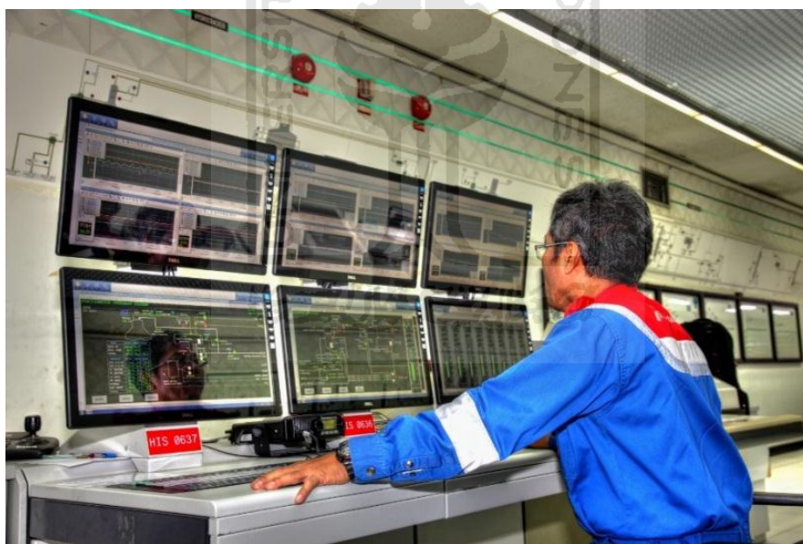
Gambar 1. 1 Pengoperasian Distributed Control System (DCS) Pada Sebuah Control Room Pertamina RU V
