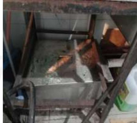
Gambar 4. 20. Kotak Filter Gestrap
