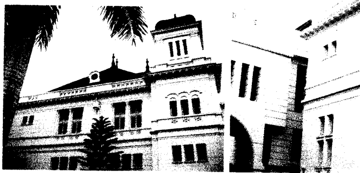
(Sumber : Survey Lapangan)
