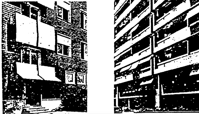
Gambar 3.8. Sun Shading (pembayangan) pada Bangunan. Sumber : Y. B. Mangunwijaya, Pengantar Fisika Bangunan .
