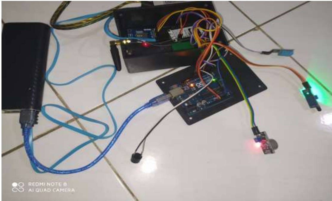
Gambar 4.1 Hardware sistem deteksi kebakaran
