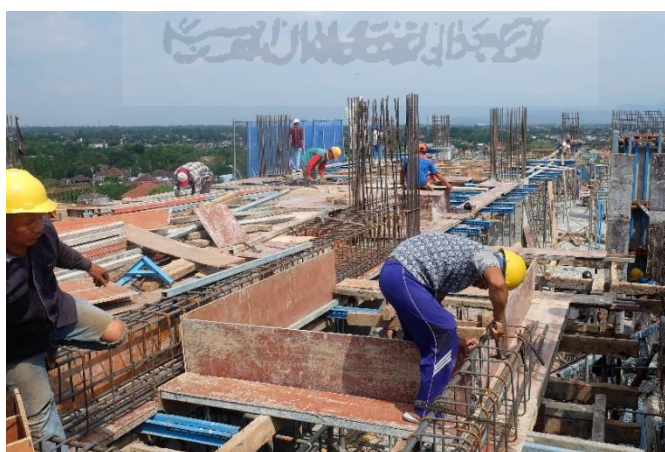
Gambar 5.7 Proses Pekerjaan Pembekistingan Balok (Sumber : Dokumentasi Pribadi, 2019)
