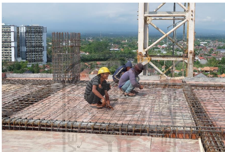
Gambar 5.10 Proses Pekerjaan Pembesian Plat Lantai
