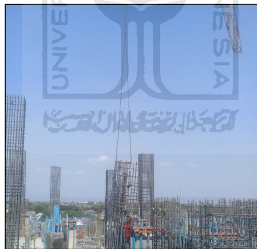
Gambar 5.2 Proses Pemasangan Tulangan Kolom
