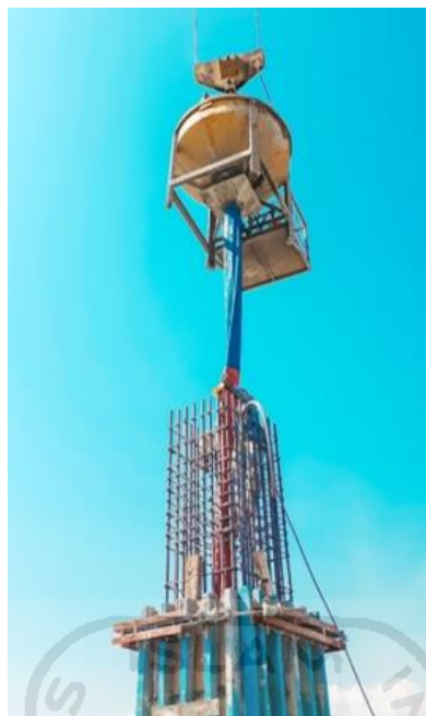
Gambar 5.5 Proses Pengecoran Kolom (Sumber : Dokumentasi Pribadi, 2019)
