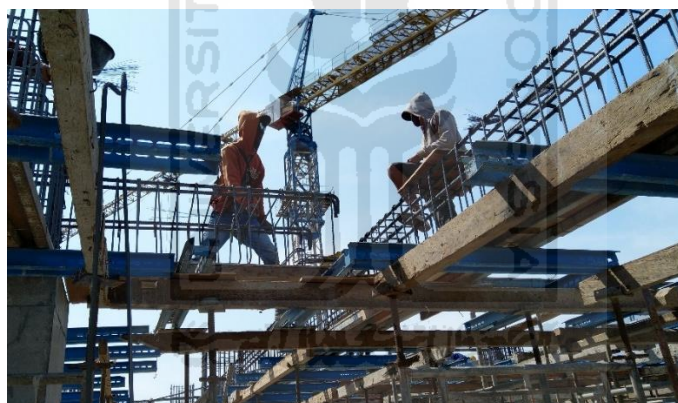
Gambar 5.6 Proses Pekerjaan Pembesian Balok
