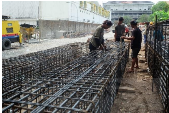
Gambar 5.1 Proses Perakitan Tulangan Kolom
