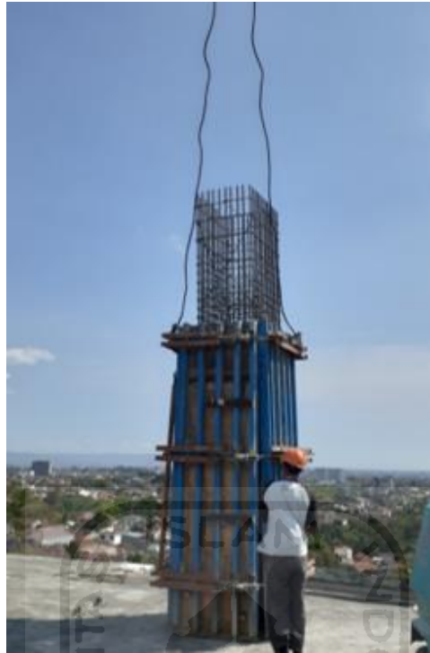
Gambar 5.3 Proses Pembekistingan Kolom (Sumber : Dokumentasi Pribadi, 2019)
