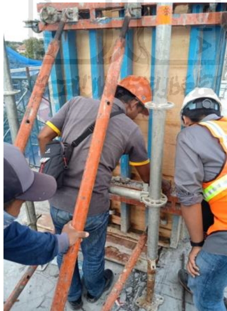
Gambar 5.4 Proses Pengecekan Vertikal Kolom (Sumber : Dokumentasi Pribadi, 2019)
