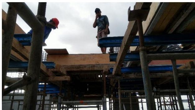
Gambar 5.9 Proses Pekerjaan Pembekestingan Plat Lantai
