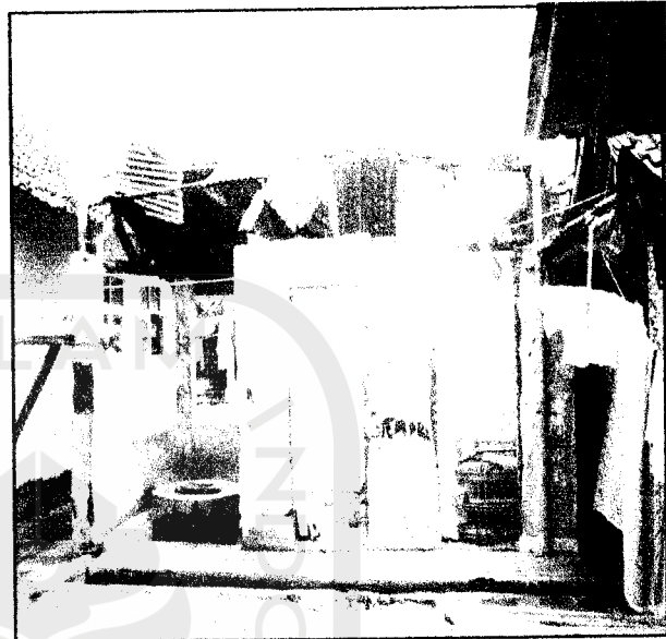
Gambar 4.12. WC umum dengan kondisi yang rusak berat Sumber : Hasil survey, Maret 2003
