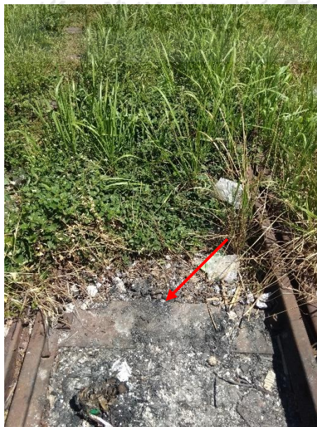
Gambar 5.16 Dokumentasi Pengamatan Bantalan Baja
