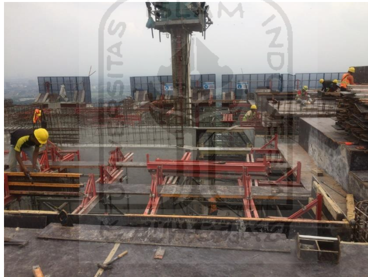
Gambar 3.7 Proses Pemakuan Tegofilm
