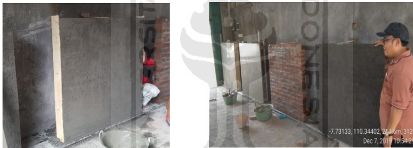
Gambar 4. 4 Dinding Pasangan Bata Merah Plester (DBMP)
