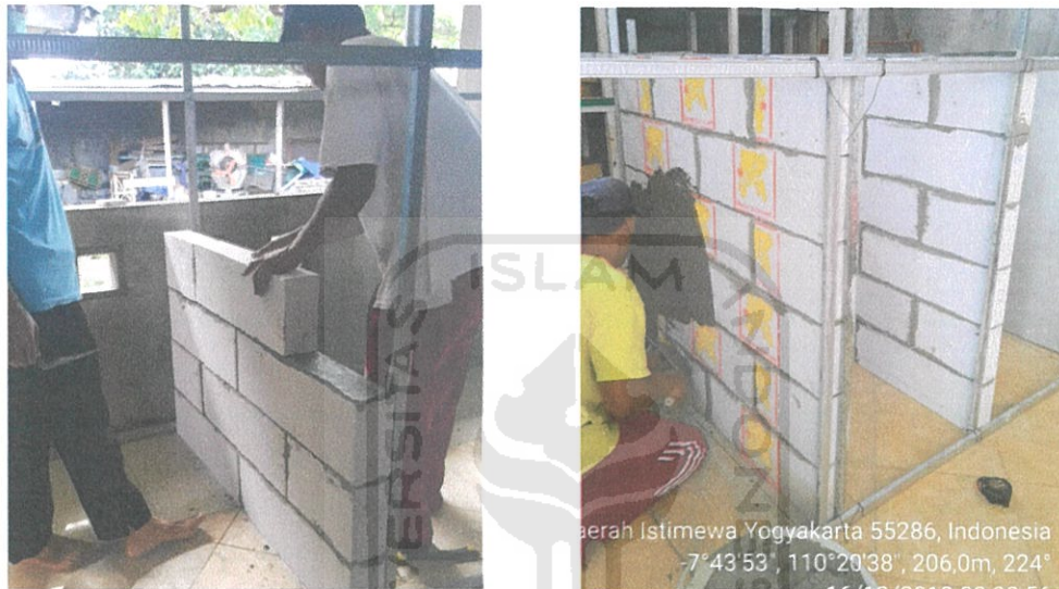
PEMBUATAN BENDA UJI DINDING BATA RINGAN SEBELUM DI PLESTER
