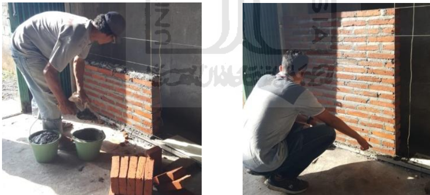
Gambar 4. 3 Dinding Pasangan Bata Merah Tanpa Plester (DBMTP)
