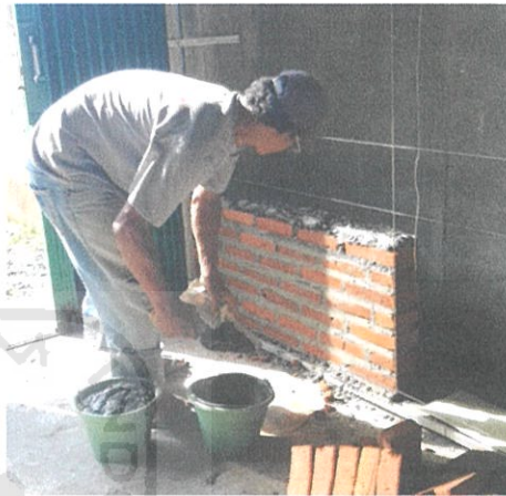
PEMBUATAN BENDA UJI DINDING BATA MERAH TANPA PLESTER (DBMTP)
