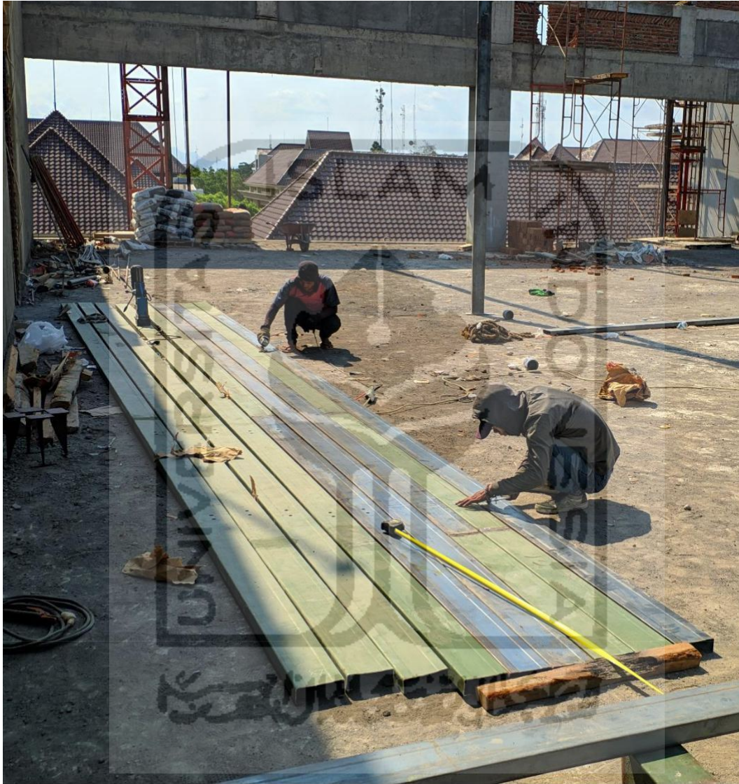
Gambar L-1.5 Pengukuran Gording (Baja CNP)
