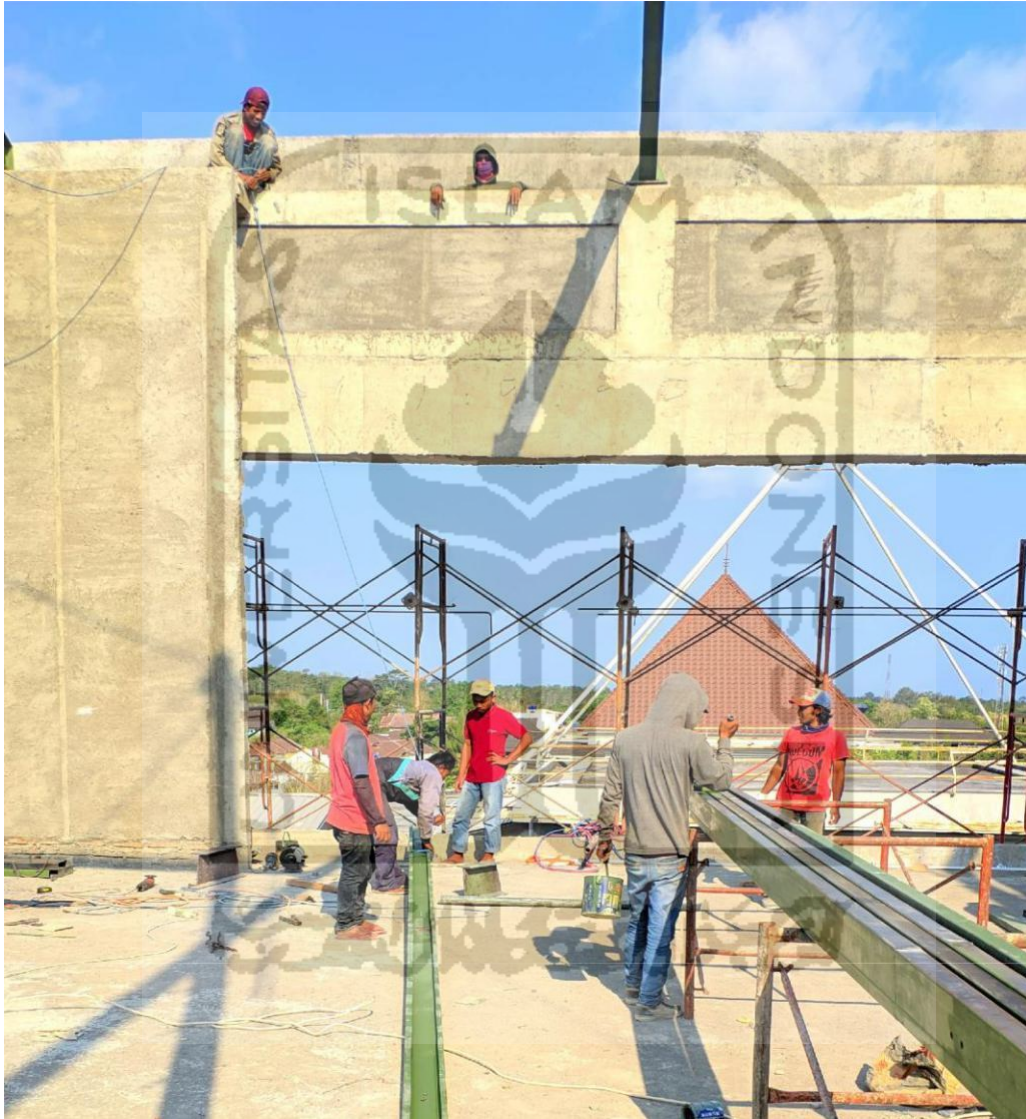
Gambar L-1.4 Pemasangan Gording (Baja CNP)
