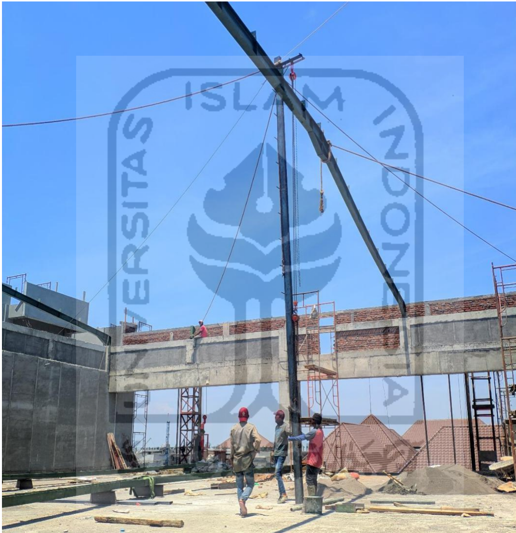
Gambar L-1.3 Pemasangan Kuda-kuda
