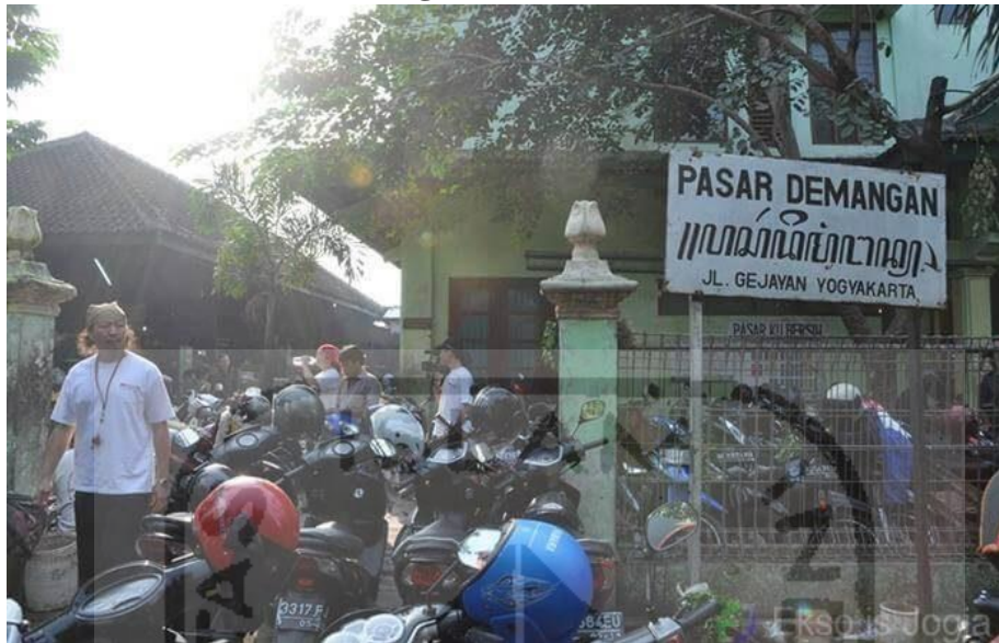
(Gambar 2.2.5.1 Foto fasad depan pasar demangan)
