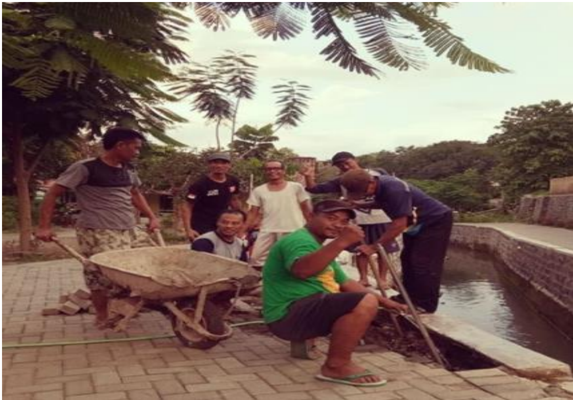
Gambar 4. 19 Kerja bakti perbaikan jalan berlubang
