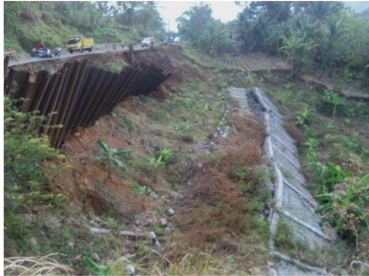
Gambar 1. 1 Kelongsoran Yang Sudah Ditangani Dengan Perkuatan Pergerakan Tanah
