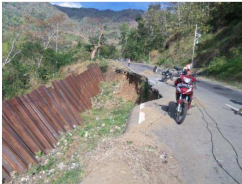
Gambar 1. 2 Gerakan tanah jenis nendatan dan Nampak penanggulangan gerakan tanah yang dilakukan terbawa lagi oleh gerakan tanah.
