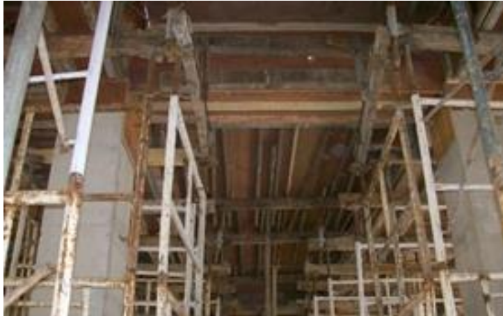
Gambar 3.4 Pekerjaan Bekisting Plat Lantai 1
