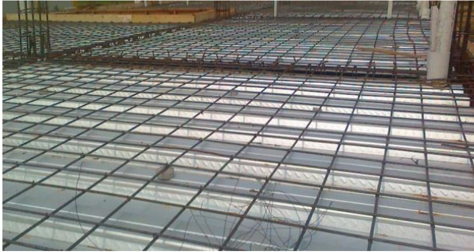
Gambar 3.6 Pelat Lantai Dengan Bondek (Sumber : https://soalanav.blogspot.com/ )
