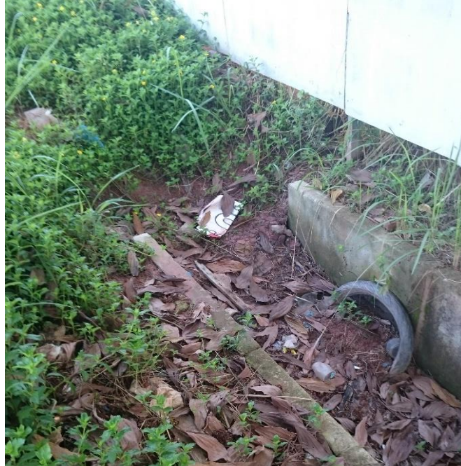
Gambar 5.10 Saluran yang Tertimbun Oleh Tanah
