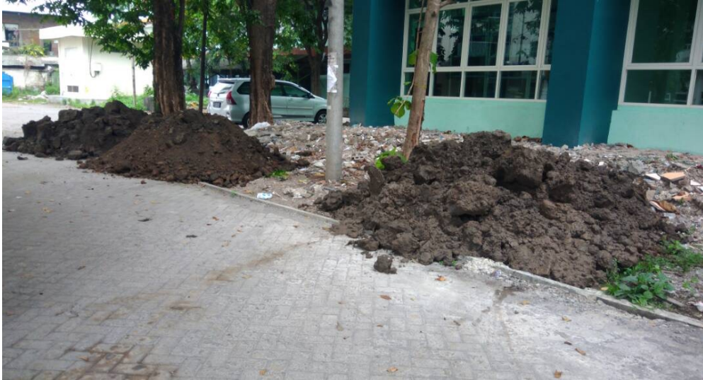
Gambar 5.5 Lokasi pembuangan tanah galian
