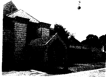
Gambar 5, Gedung Studio Audio Visual TVRI Stasiun Yogyakarta
