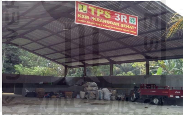
Gambar 2.14 TPS 3R Kranggan Sehat, Kranggan, Kulon Progo.
