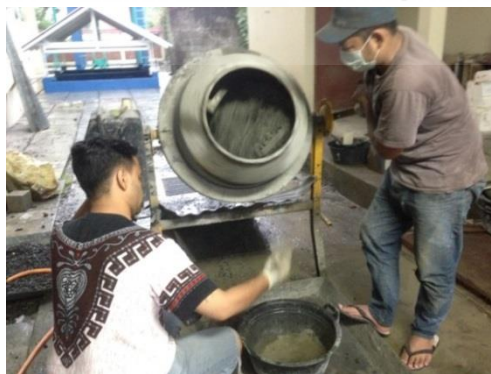
Gambar L.49.3. Proses pengadukan campuran material menggunakan mesin pengaduk/mixer
