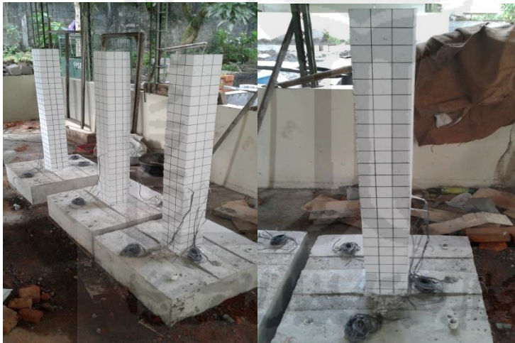
18. Pembuatan pola pada benda uji kolom beton bertulang
