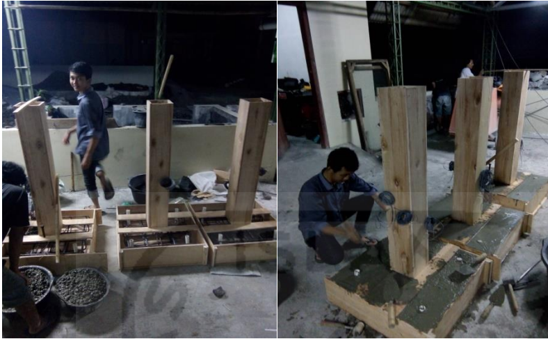
16. Pengecoran dan pematatan
