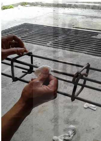
11. Penghalusan dan pembersihan permukaan baja tulangan untuk strain gauge
