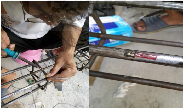
12. Pemasangan strain gauge pada baja tulangan
