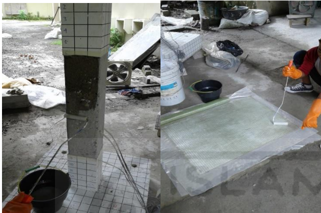
22. Pemberian epoxy pada kolom dan GFRP
