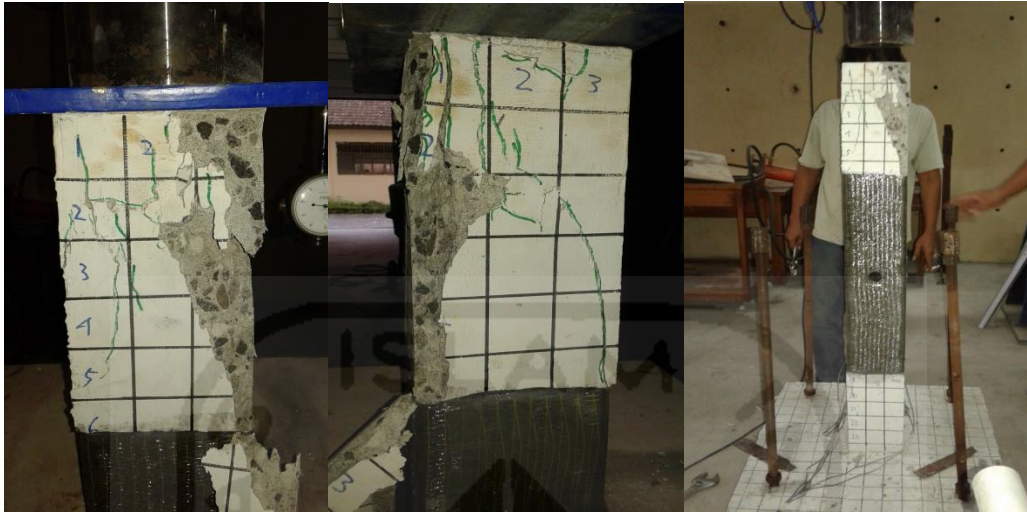
27. Pola kerusakan kolom GFRP-1 (KG1)
