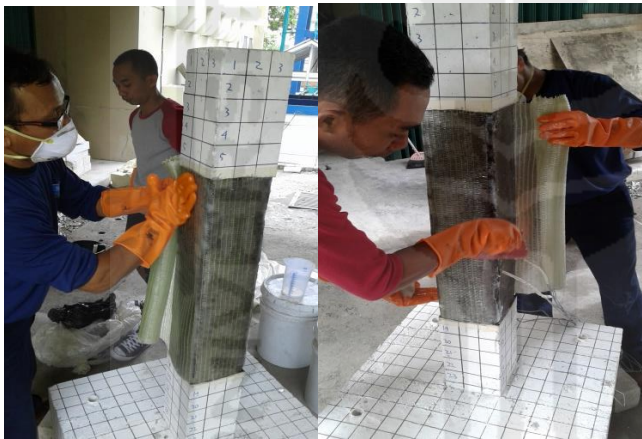
23. Pengaplikasian GFRP pada kolom beton bertulang
