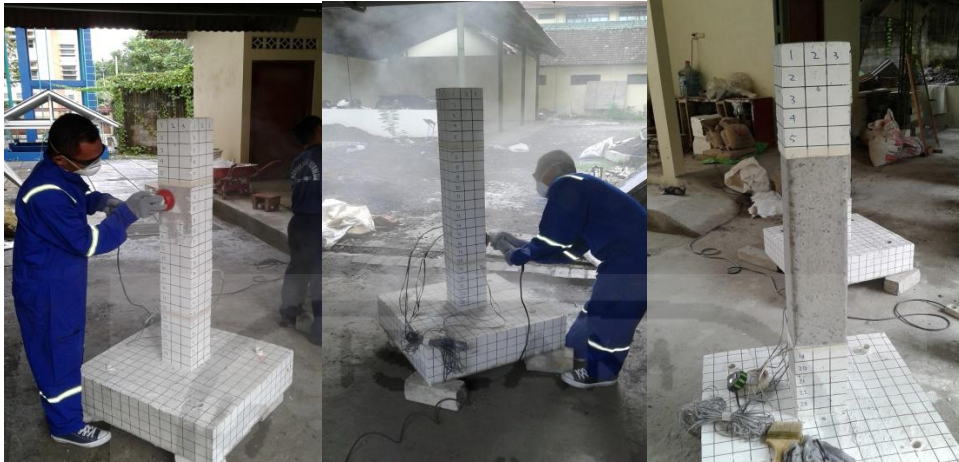
19. Persiapan sebelum dilakukan pengaplikasian GFRP pada kolom
