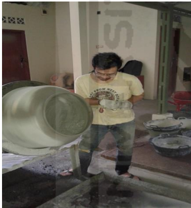
14. Pembuatan beton segar untuk kolom dan pondasi
