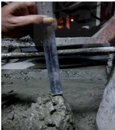
15. Pengukuran tinggi slump kolom dan pondasi
