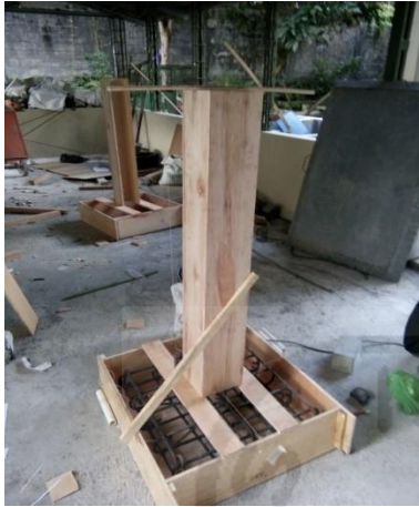
13. Pemasangan baja tulangan pada bekisting
