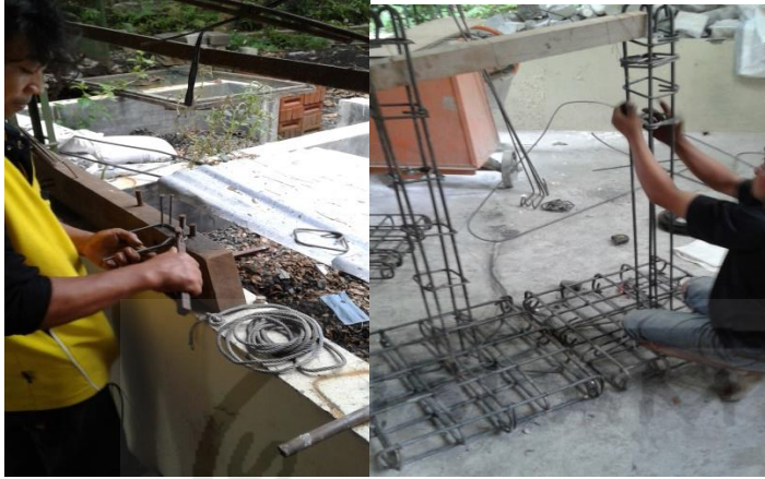
10. Perakitan tulangan kolom dan pondasi
