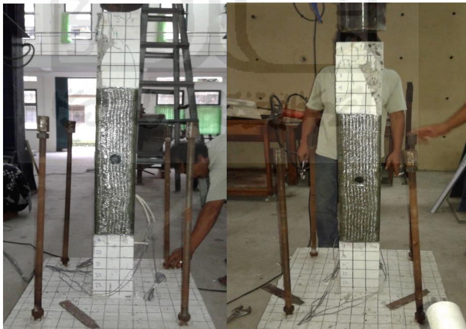
Gambar 5.17 Kerusakan Kolom Glass 1 (KG1)
