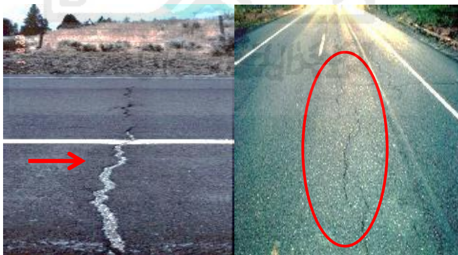
Gambar 3.7 Retak Memanjang dan Melintang (Sumber : Hafid, 2013)
