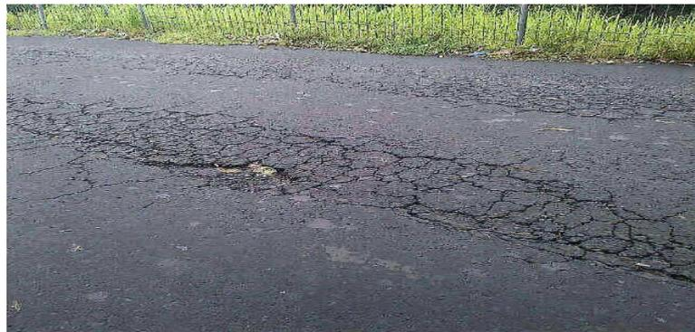
**Gambar 5.8.** Retak Kulit Buaya di salah satu segmen di jalan Amol Mononutu, Ternate
