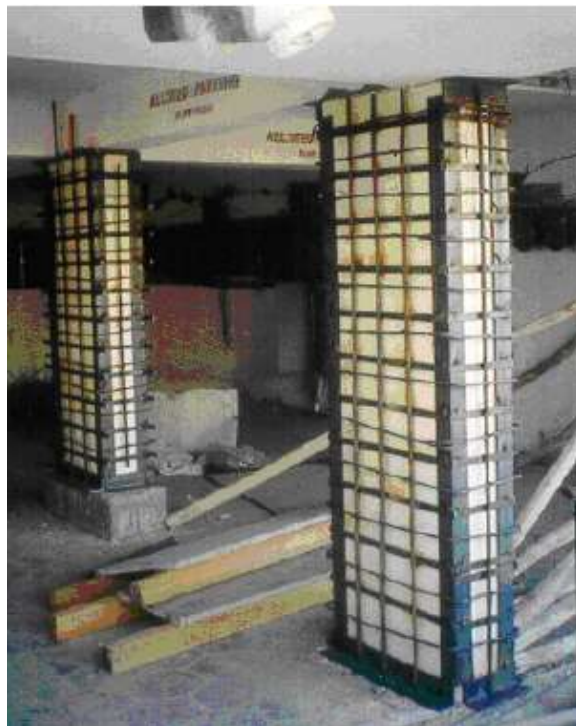
Gambar 3.32 Jacketing yang kurang tepat, baja siku disambungkan dengan pengelasan dalam arah vertikal, sambungan tidak menerus (Murty et al , 2009)
