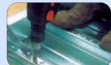
Step 7 Fix steel edge form
