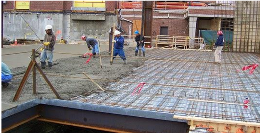
Gambar 3.5 Gambar Penulangan Pelat Lantai Dengan Bondek (Sumber : http://pabrikgalvalummurah.blogspot.co.id/2015/01/cara-memasang-bondek-atau-superdek.html , 2017 )
