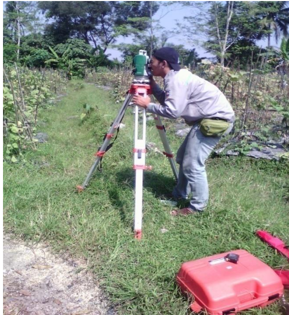
Gambar 7.3 Pengukuran Elevasi Kondisi Eksisting
