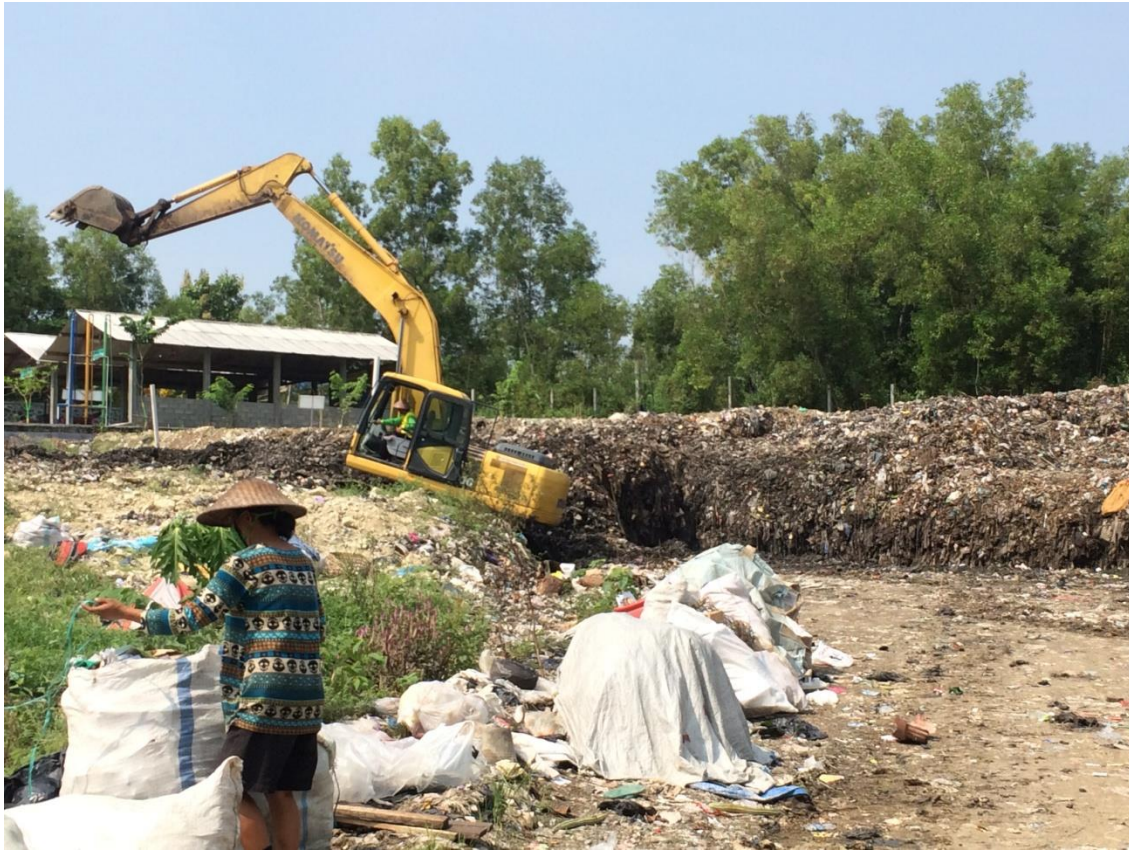
Gambar Lampiran 3. Kegiatan penimbunan sampah oleh petugas TPA Banyuroto. Penimbunan dilakukan ketika timbunan sampah setinggi 0,5 meter. Kegiatan penimbunan yang dilakukan petugas menjadi hambatan bagi pemulung karena pemulung harus menghentikan aktivitasnya sementara.
