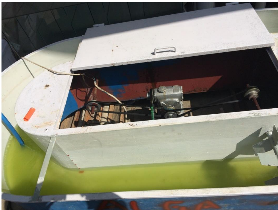
Gambar 5 Pengisian oxidation ditch untuk running
