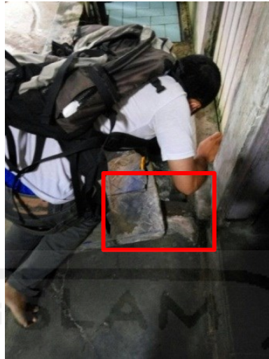
Gambar 4.3 Kondisi tangki septik di dalam rumah
