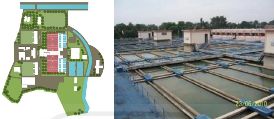
Gambar 2.18 Bangunan Pulsator
